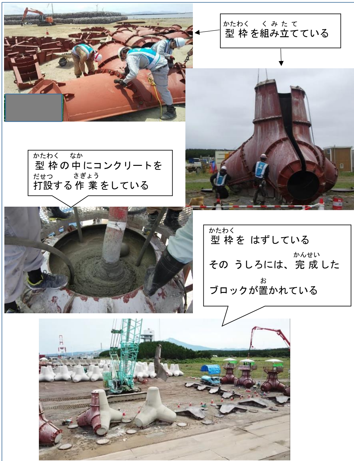
ず せいさく 図-74 ブロックの製作の ようす
