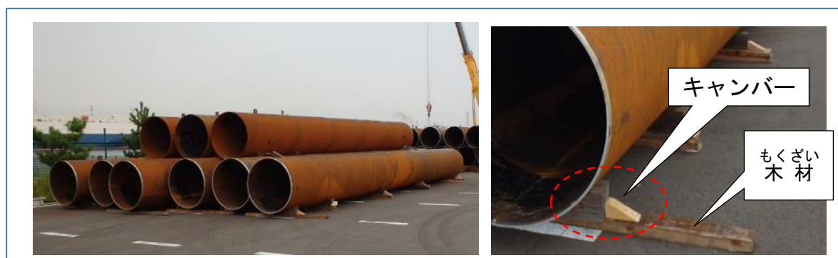
ず 図-53 こうかんくい お 鋼管杭を置いているようす
