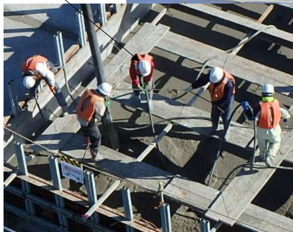
ず せん つか 図-94 コンクリートミキサー船を使った だせつ コンクリートの打設の ようす
