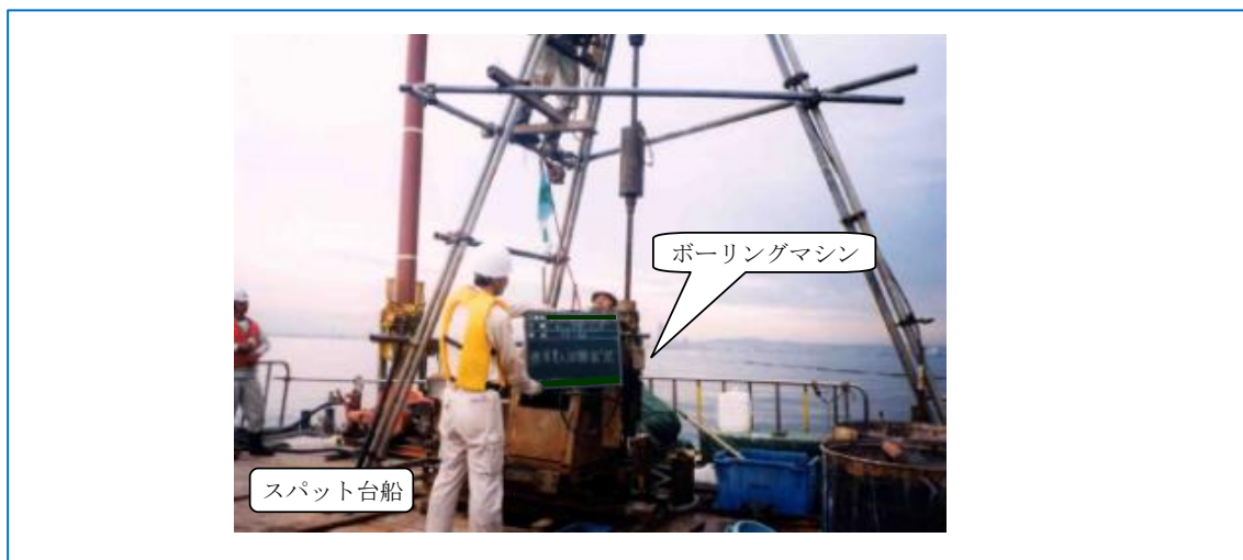
ず 図－37 チェックボーリングのようす
