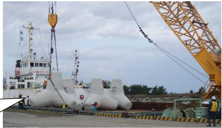
ず しょうは つ 図-75 消波ブロックのトレーラーへの積みこみと さぎょうせん つ さぎょう 作業船への積みこみ作業の ようす
