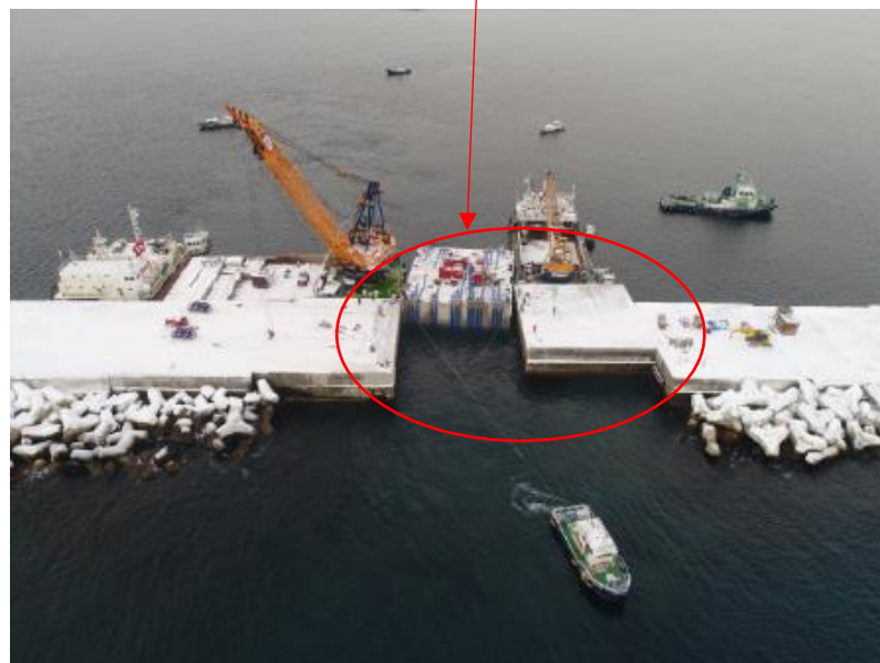
ず ぼうはてい こうじ おこな さぎょうせん 図－7 防波堤の工事を行う作業船
