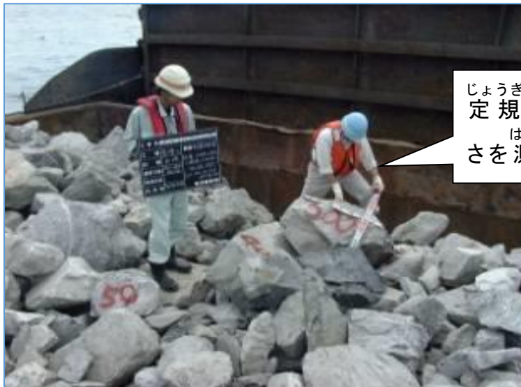
図－66 基礎捨石の大きさや形を確認している ようす
