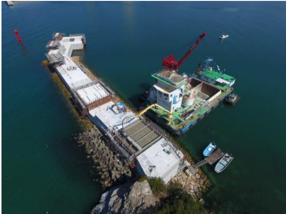
図-93 コンクリートミキサー船を打設場所に 係留しているようす
