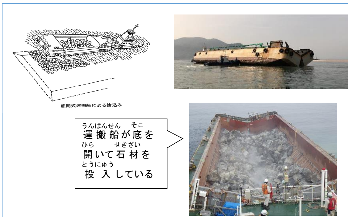
図-61 底開き式 運搬船による基礎捨石投入の ようす
