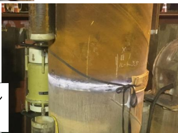
ず こうかんくい た 図-58 鋼管杭の つぎ足し と ようせつ かくにん 溶接の確認の ようす
