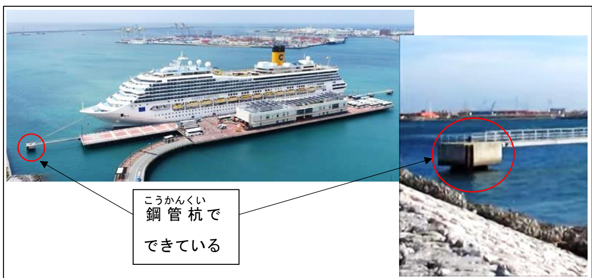
ず 図-43 こうかんくい れい 鋼管杭で つくったドルフィンの例
