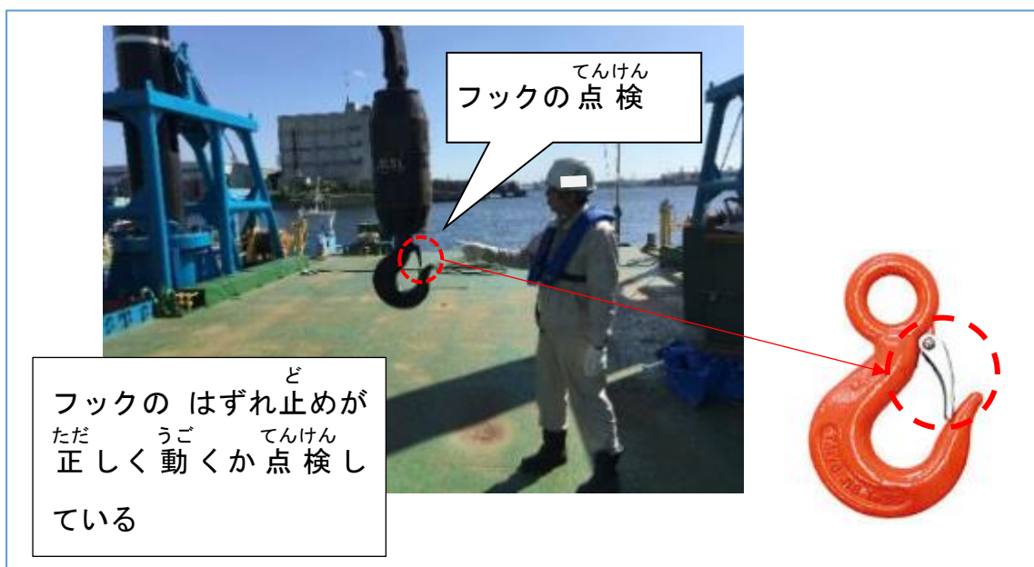
図-116 クレーンのフックの点検のようす
