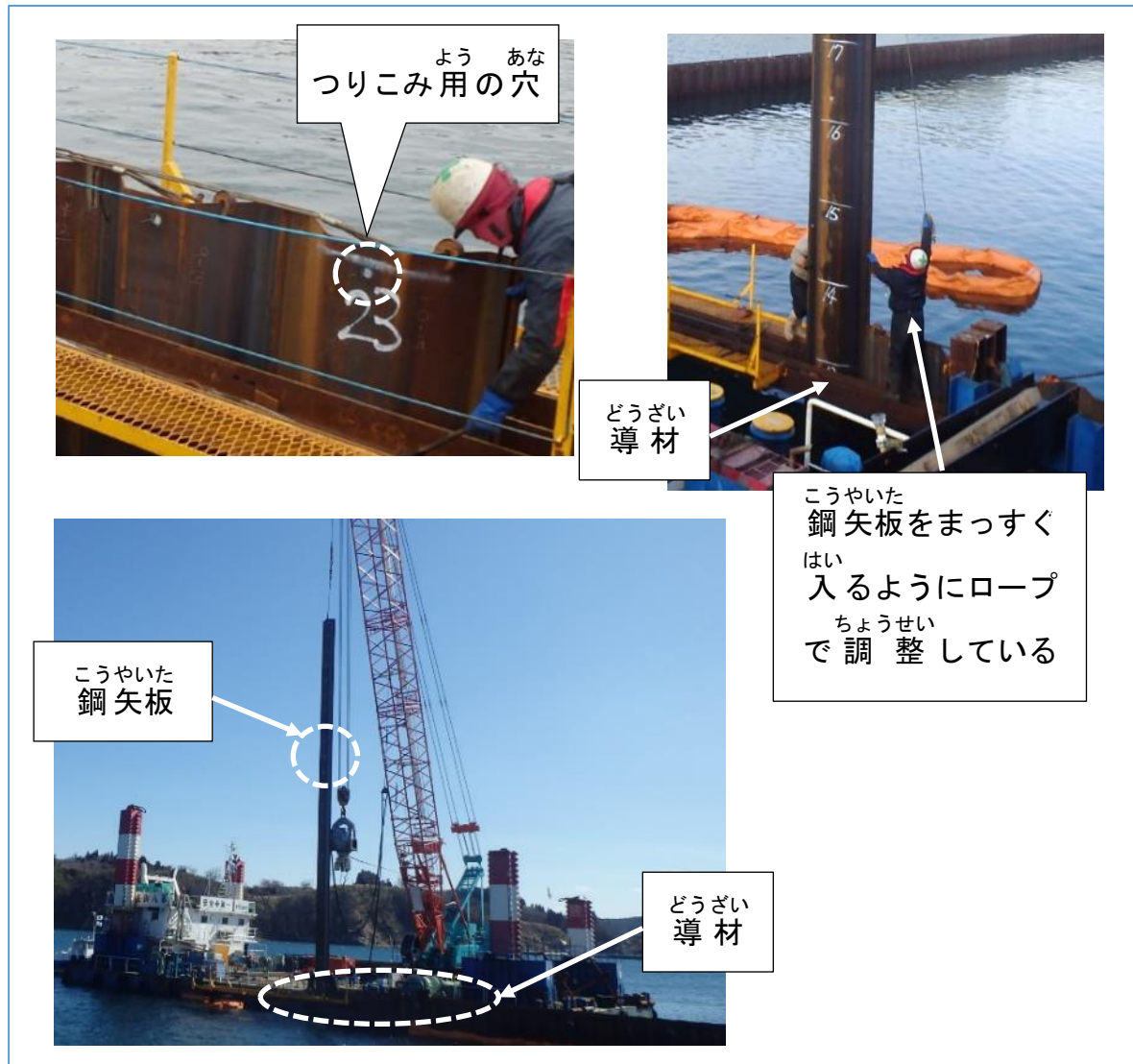
ず 図-50 こうやいた 鋼矢板をクレーンで つり上げて どうざい 導材に入れている ようす
