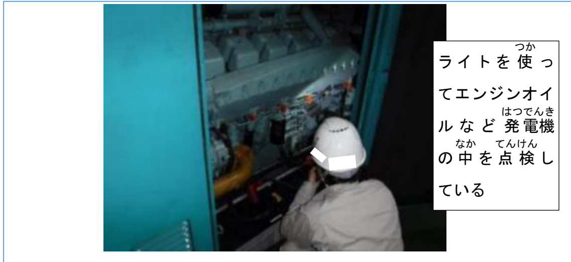
図-115 発電機の点検のようす
