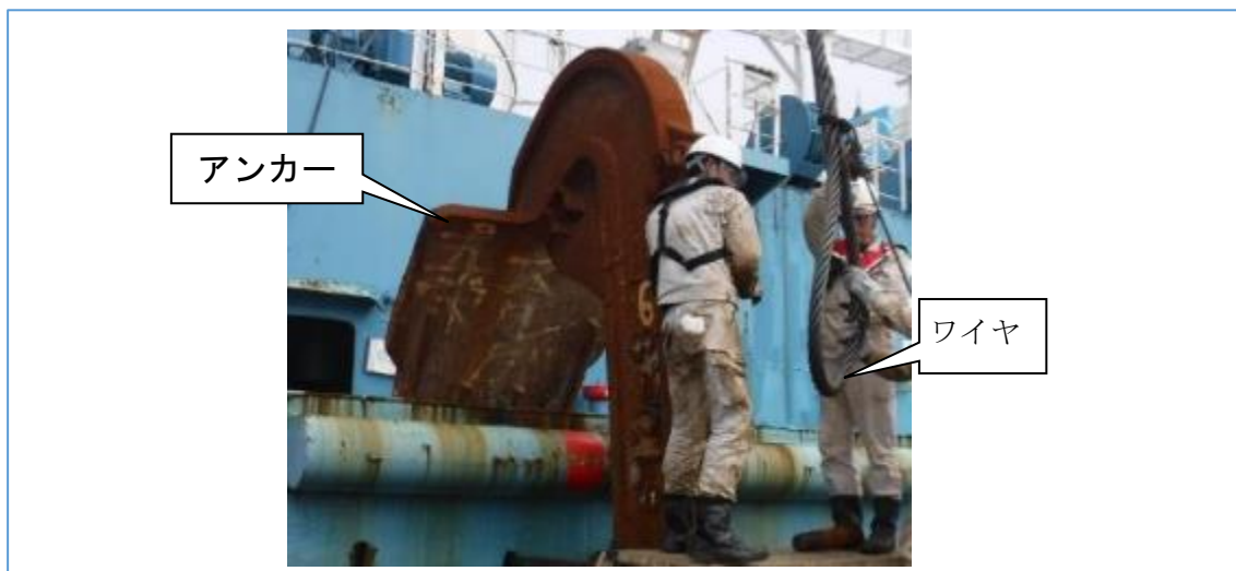
ず 図-135 アンカーにワイヤを取り付けている ようす
