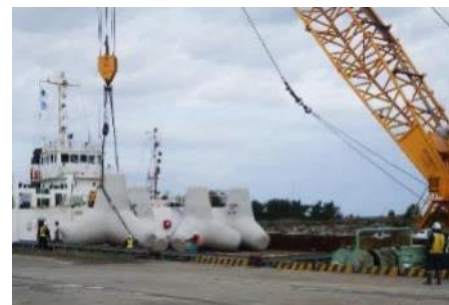
ず あ かなぐ 図-145 つり上げのための金具がないブロックの たまがけ さぎょう 玉掛作業のようす
