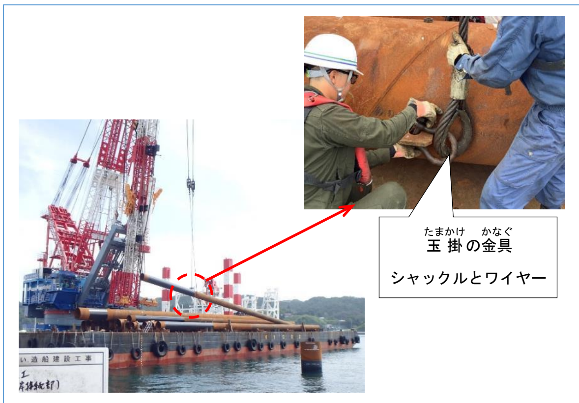
図－54 台船から杭打船への鋼管杭の つりこみ
