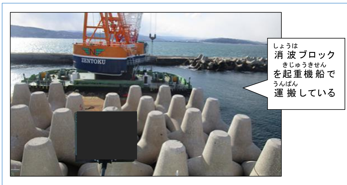
ず 図ー76 コンクリートブロックの海の運搬の ようす うみ うんぱん
