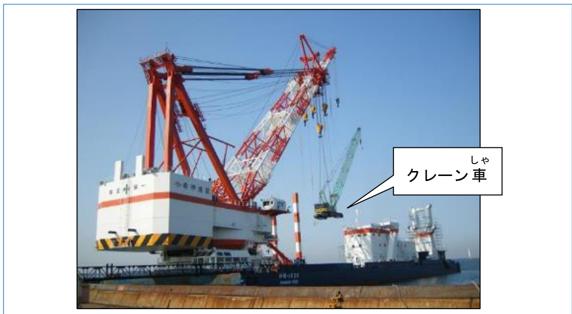
図-121 クレーン車の積みこみのようす
