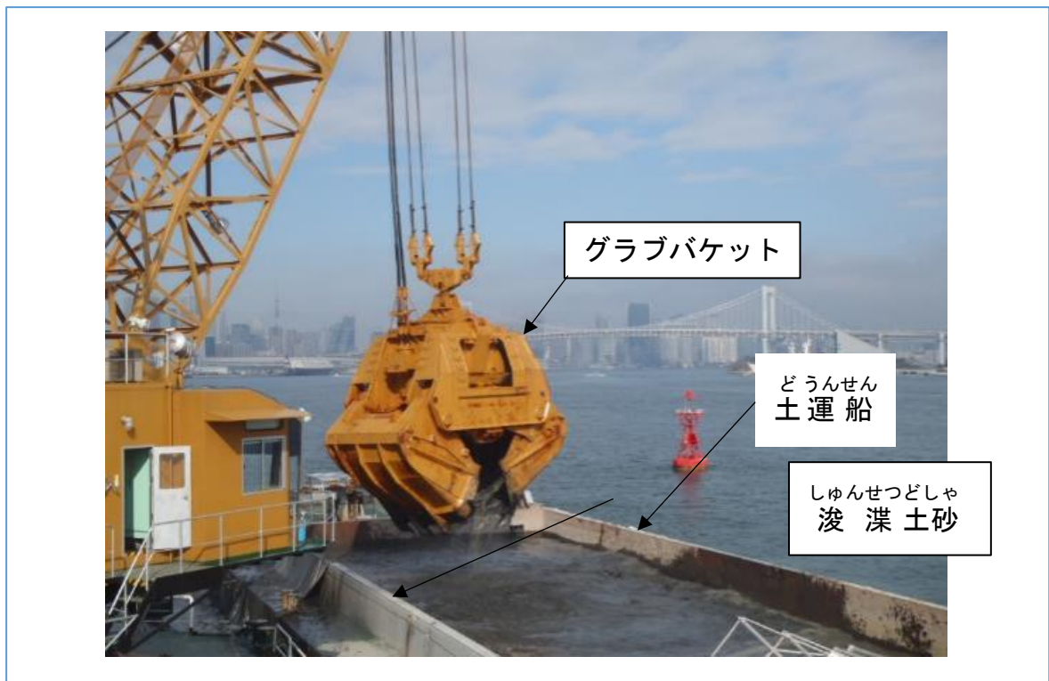
図-23 土運船への浚渫土砂の積みこみの ようす
