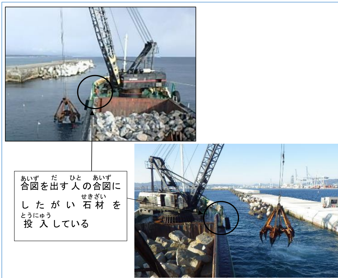
ず せきざい とうにゆう こうじ さぎょう 図-155 石材の投入工事のクレーン作業の ようす
