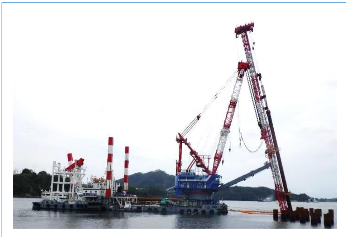
図-44 杭打船をつかって鋼管杭を打ちこんでいるようす
