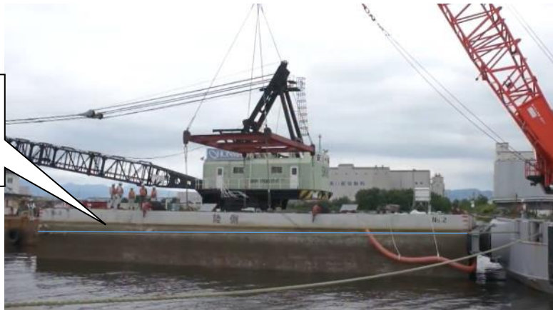
ず 図-85 ケーソンに えい航のためのロープをかける ようす
