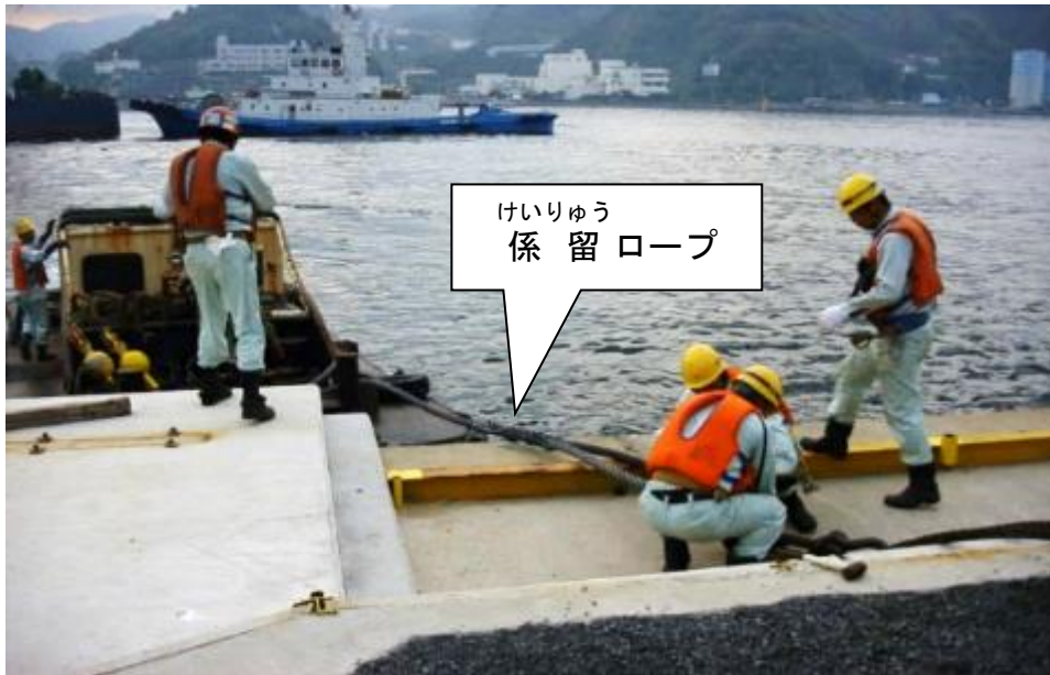
図－129 係留ロープを係船柱にかける ようす
