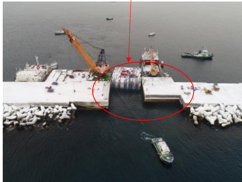
図-7 防波堤の工事を行う作業船
