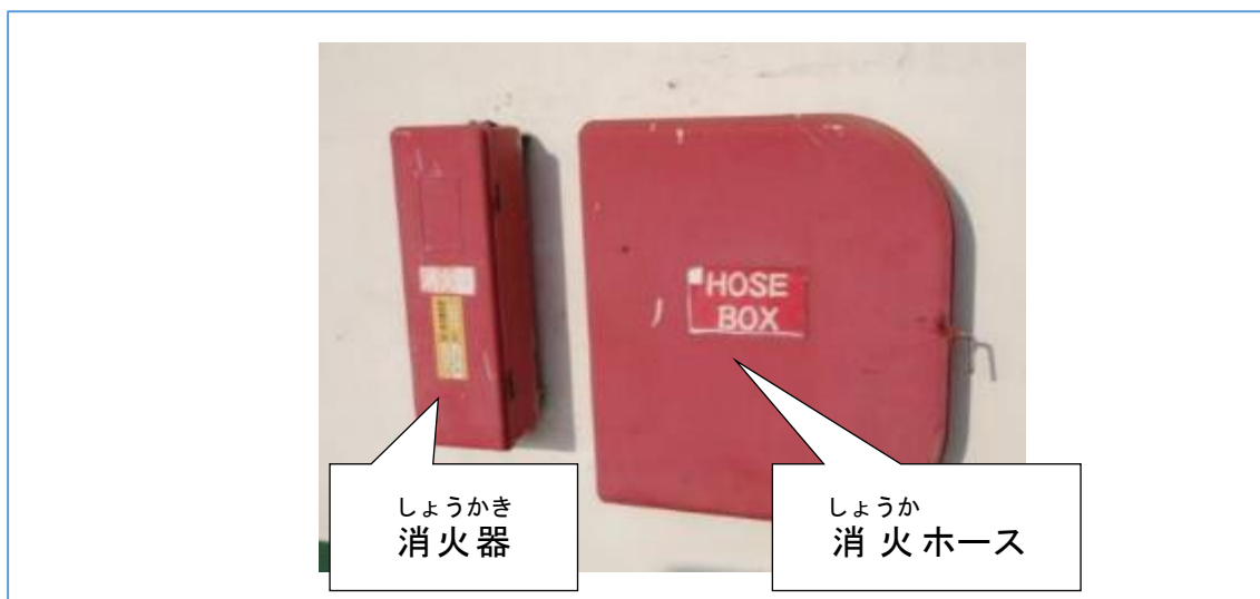
ず しょうか せつび 図－111 消化設備
