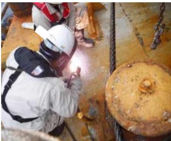
ず ようせつ こうはん なお 図－120 溶接による甲板を直しているようす
