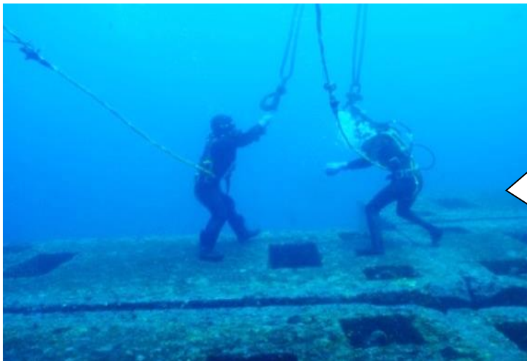
ず すえつけこうじ 図-77 ブロックの据付工事のようす
