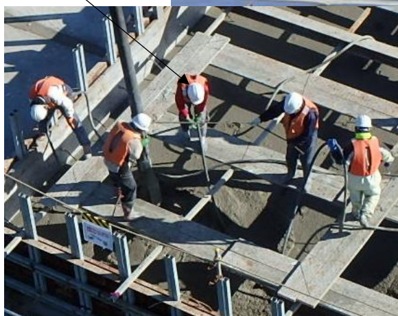
図-94 コンクリートミキサー船を使った コンクリートの打設のようす
