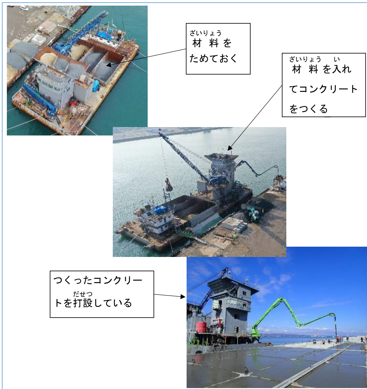
ず 図－90 コンクリートミキサー船の例 せん れい
