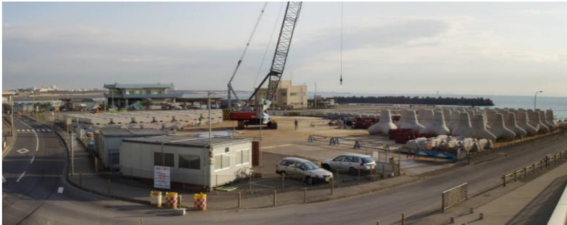
図-72 製作ヤードでの コンクリートブロック製作工事のようす
