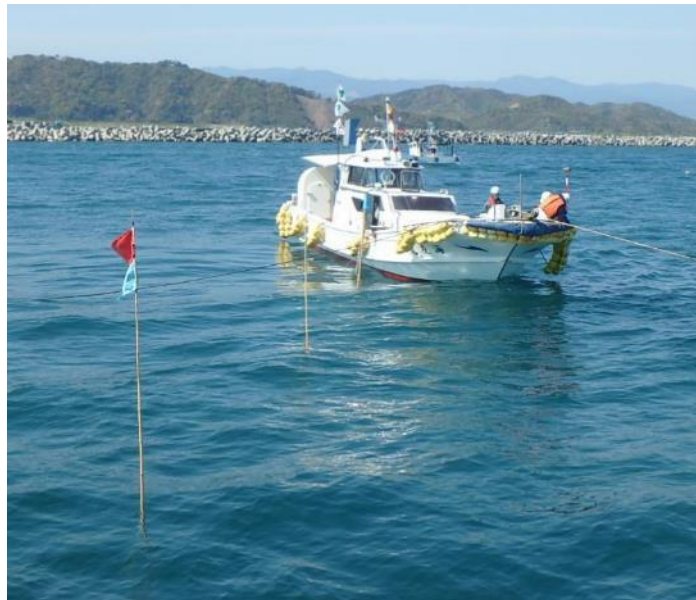
図-100 GPSによる海の測量と測量の目標のための旗竿 の設置のようす
