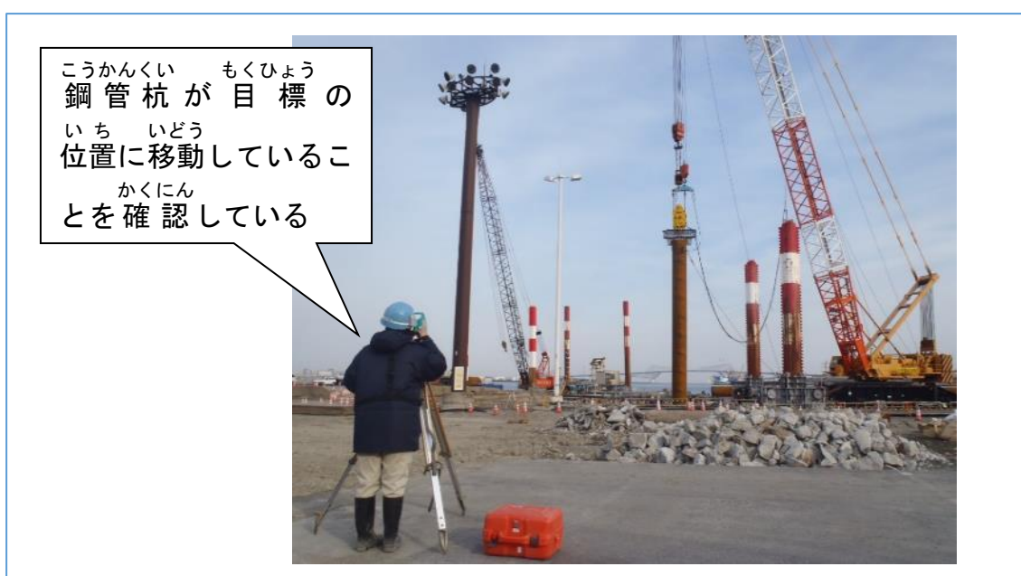
図-56 鋼管杭を目標の場所に移動している ようす
