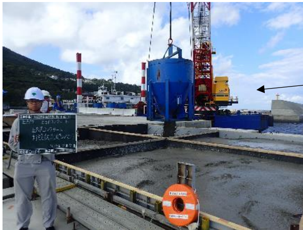
ず 図-89 バケットによるコンクリート だせつ こうじ 打設工事
