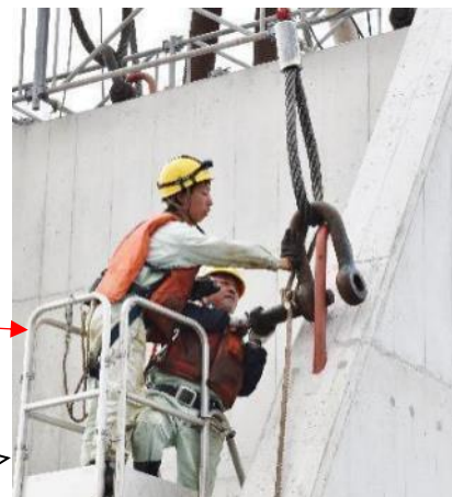
ずたまがけさぎょう れい 図－138 玉掛作業の例
